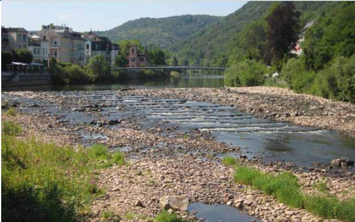
Barrierefrei: das Elisabethenwehr nach dem Umbau.
