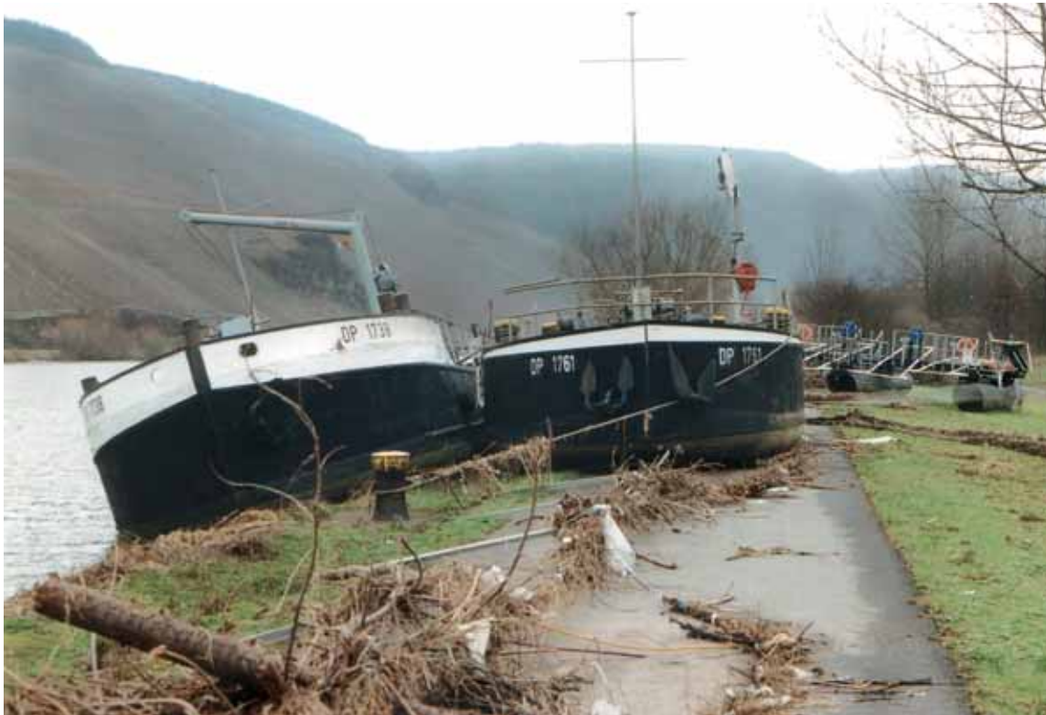
„Spuren“ des Moselhochwassers 1995 an der Staustufe Detzem
