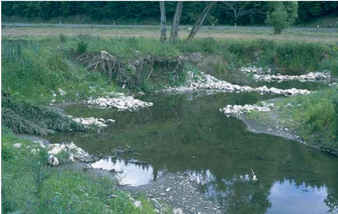
Beispiel einer Renaturierungsmaßnahme: Geschiebedepot zur Förderung der Eigendynamik
