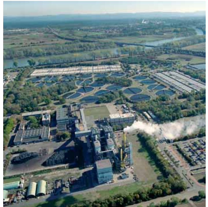
Kläranlage der BASF AG, Ludwigshafen
